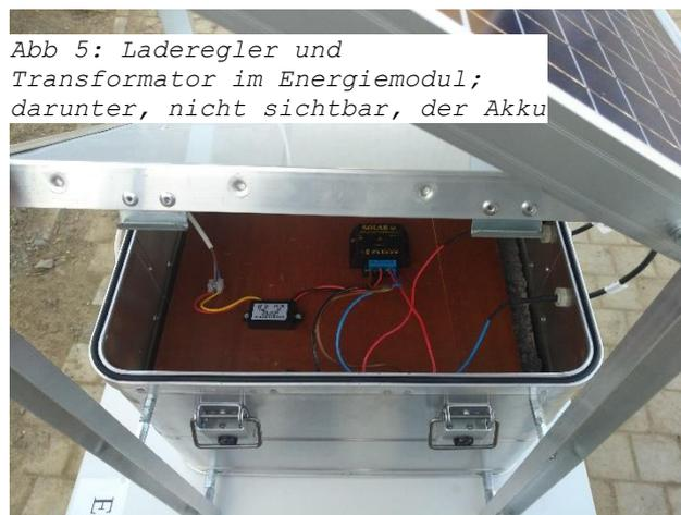
Abb 5: Laderegler und Transformator im Energiemodul; darunter, nicht sichtbar, der Akku
